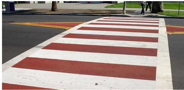
Attēls Nr. 11 Paceltās gājēju pārejas piemērs ar sarkanu-baltu-sarkanu krāsojumu 12
