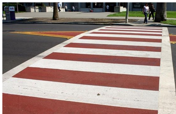
Attēls Nr. 26 Paceltās gājēju pārejas piemērs ar sarkanu-baltu-sarkanu apzīmējumu 27
