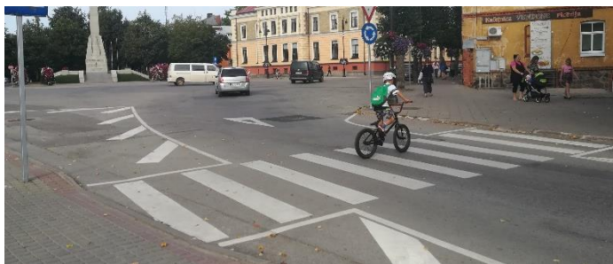
Attēls Nr.4. Vizuāli sašaurināts krustojums ar gājēju pāreju, Cēsis 5
