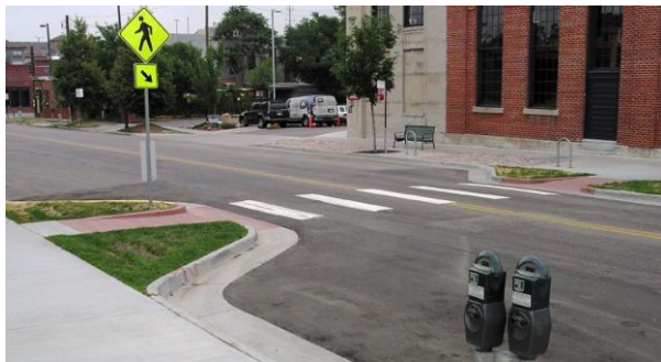
Attēls Nr.18 Ielas sašaurinājums ar gājēju pāreju 19
