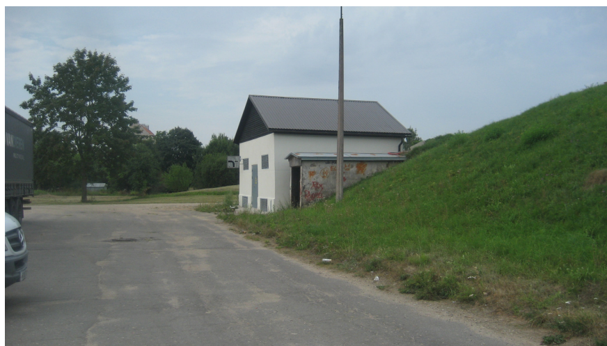
3.foto. Skats uz plānojamajā teritorijā esošo elektrisko tīklu transformatoru apakšstaciju.
