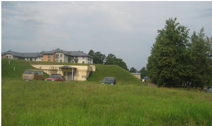
5.foto. Skats uz plānojamajā teritorijā esošo būvi, bijušo civilās aizsardzības objektu – patvertni.
