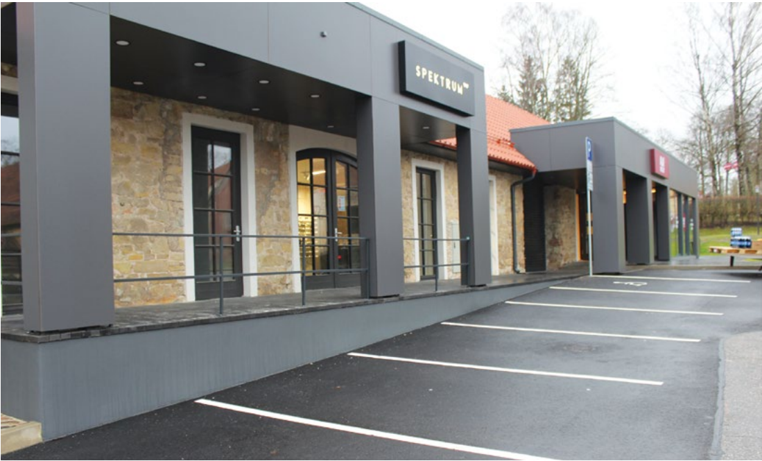
Attēlā: Publisko ēku grupā augstāko novērtējumu saņēma objekts Lenču ielā 6 - saimnieciskās ēkas pārbūve par komerciāla rakstura celtni. Foto: Aivars Akmentiņš.
