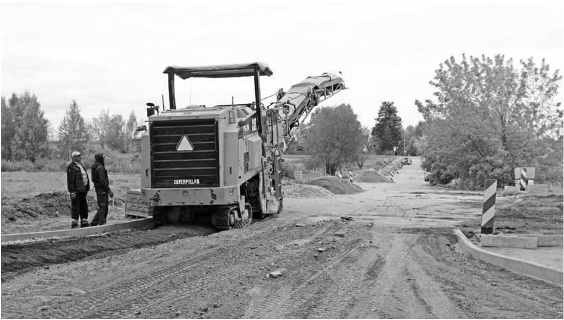
Attēlā: Daļā no rekonstruējamā Ata Kronvalda ielas posma SIA “GP Holding” meistari veco asfalta klājumu jau ir nofrēzējuši. Foto: Aivars Akmentiņš.
