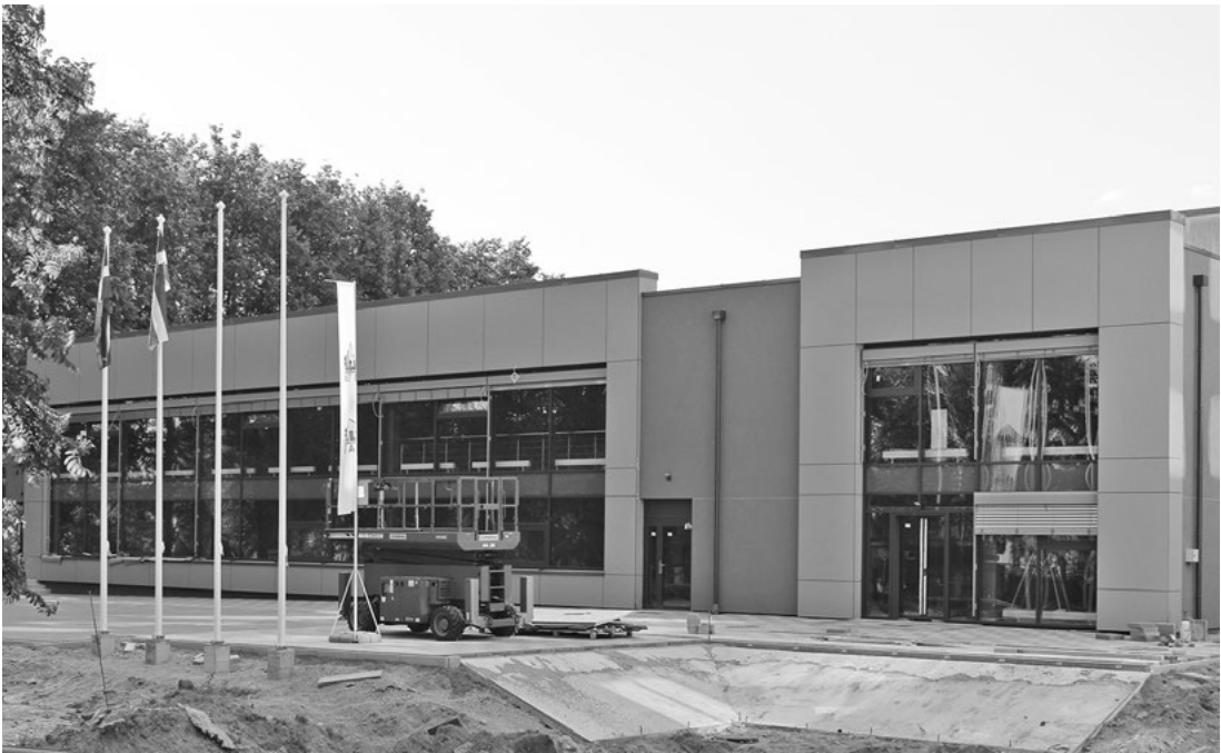
Attēlā: Cēsu Pilsētas vidusskolas piebūves būvdarbus plānots pabeigt augustā. Septembrī vidusskolas audzēkņi jau varēs mācīties jaunajās telpās. Foto: Aivars Akmentiņš.
