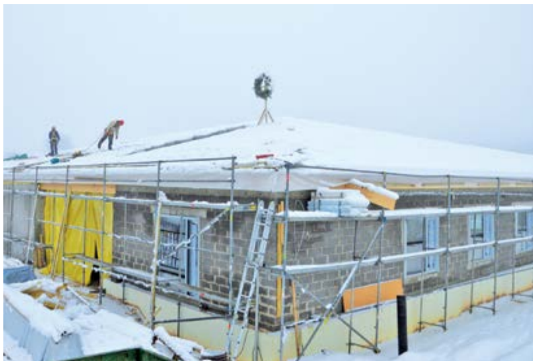
Attēlā: Sociālo pakalpojumu centram "Cēsis" pabeigti ēkas pamatkonstrukciju būvdarbi un nosvinēti spāru svētki. Foto: Kārlis Pots.
