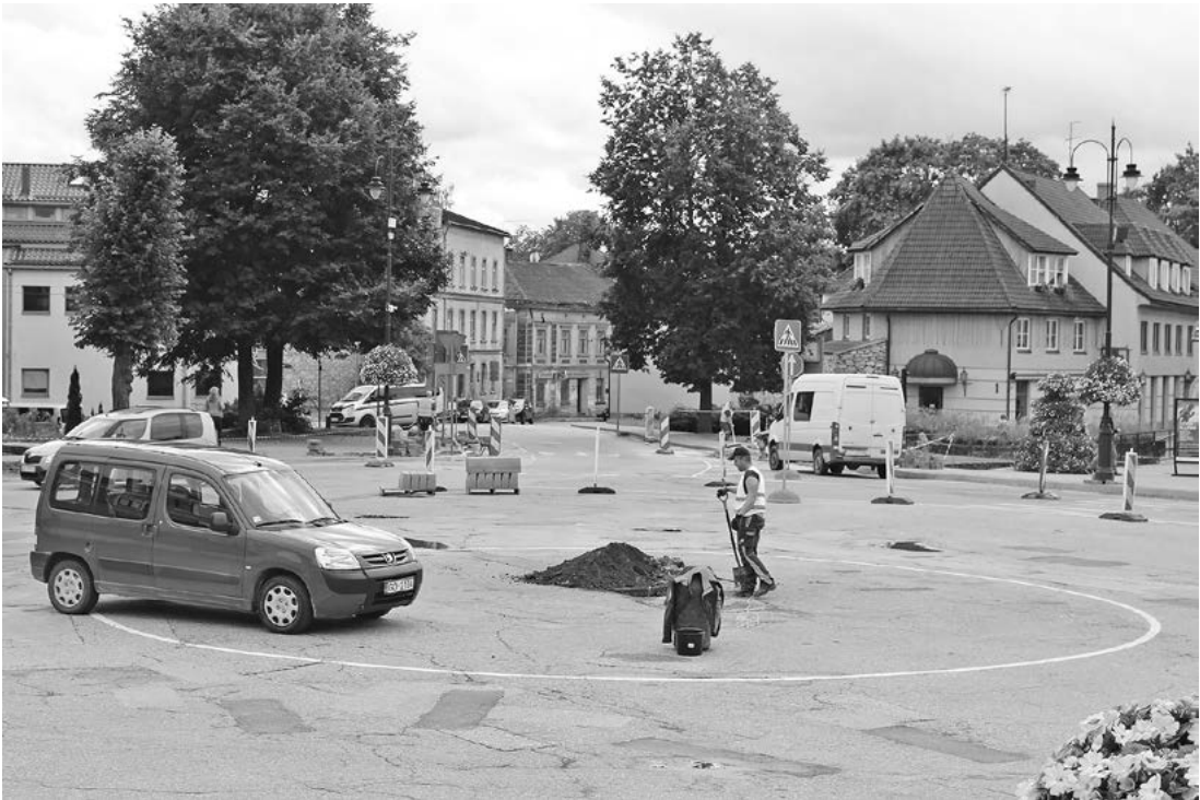
Attēlā: Vasaras otrajā pusē Cēsis sākušies ļoti apjomīgi ielu un ietvju seguma atjaunošanas darbi. Foto: Aivars Akmentiņš.
