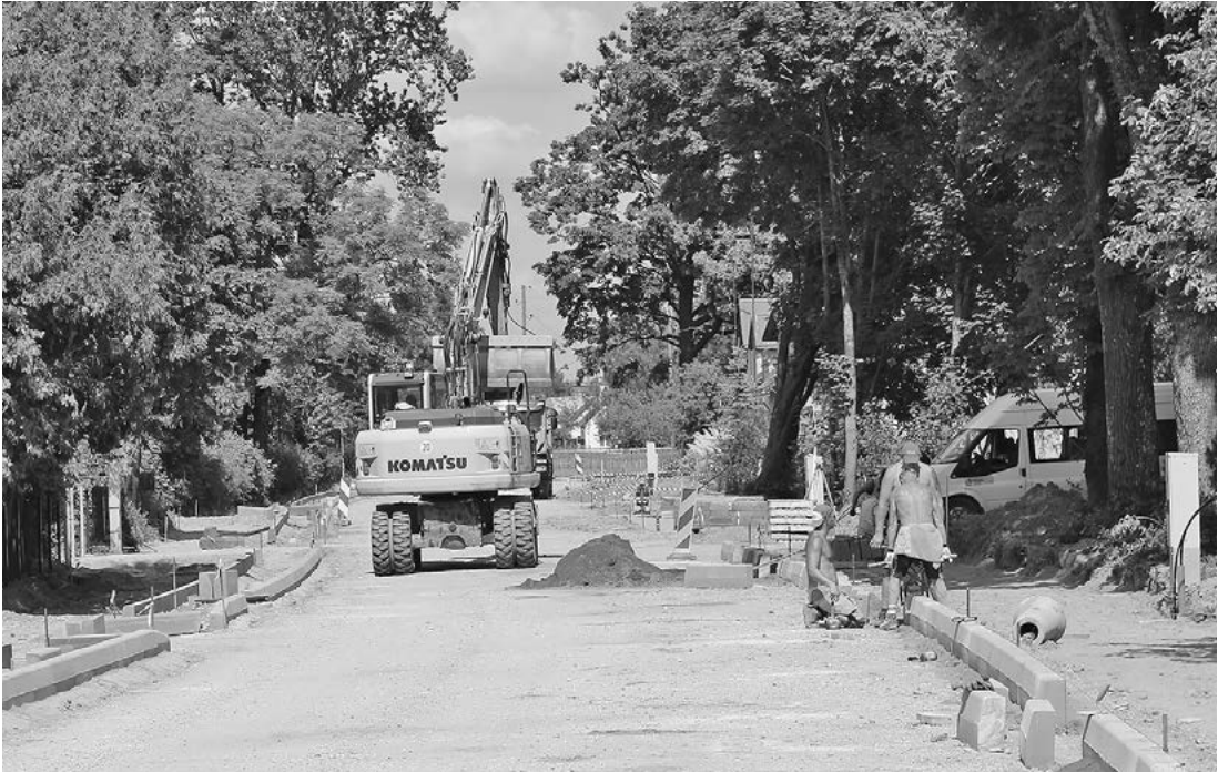
Attēlā: Ata Kronvalda ielas pārbūve norit posmā no Valmieras ielas līdz Jāņa Poruka ielai. Foto: Aivars Akmentiņš
