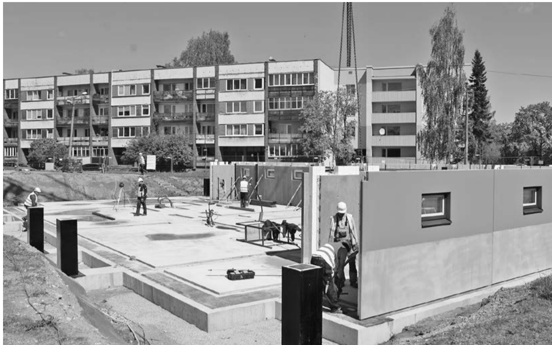
Attēlā: "Siguldas Būvmeistara" amatnieki jau montē daudzdzīvokļu nama pagrabstāva paneļus un sola, ka novembrī pirmie iemītnieki tiks pie savu jauno dzīvokļu atslēgām. Foto: Aivars Akmentiņš.
