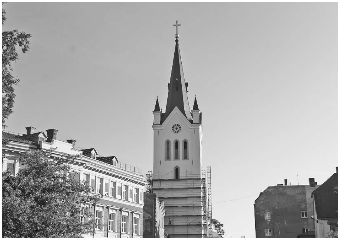
Attēlā: Plānots, ka Cēsu Sv. Jāņa baznīcas restaurācijas darbi noslēgsies gada nogalē. Septembrī vēsturiskajai ēkai noņemts aizsargtīkls, kas to slēpa skatieniem visu vasaru. Foto: Aivars Akmentiņš.
