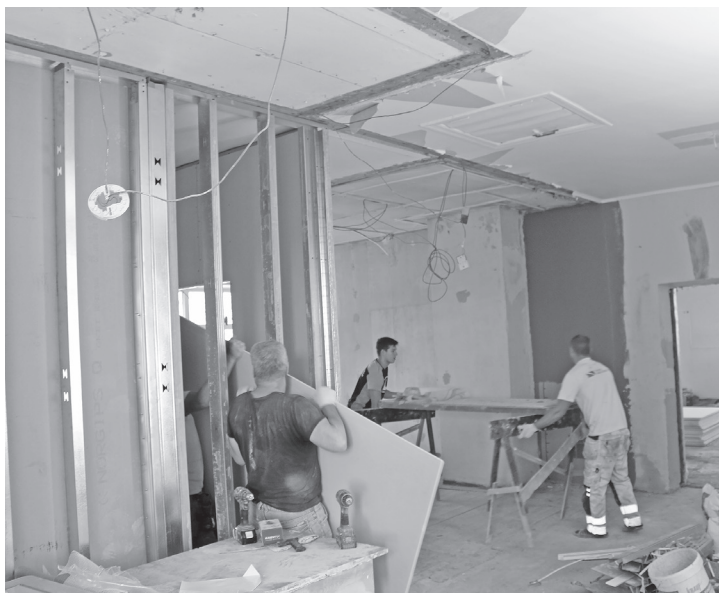
Attēlā: Līvu sākumskolas otrajā stāvā rit remontdarbi. Trīs klašu telpās tagad būs mājvieta vēl vienai bērnudārza grupiņai. Foto: Aivars Akmentiņš.
