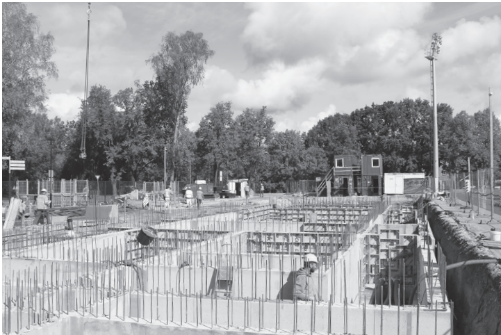
Attēlā: Šobrīd pabeigta būvbedres rakšana un sagatavota pamatne betonēšanai. Foto: Aivars Akmentiņš.
