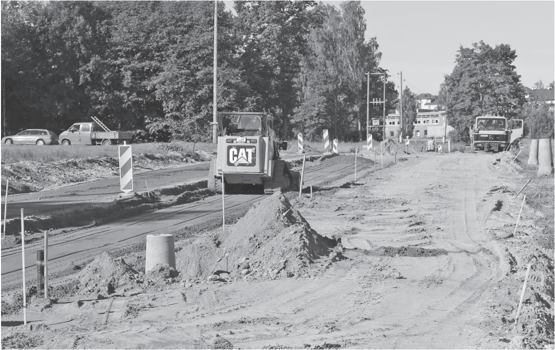
Attēlā: Darbi Cīrulišu ielā norit pakāpeniski, lai to nebūtu pilnībā jāslēdz transporta kustībai. Foto: Aivars Akmentiņš.
