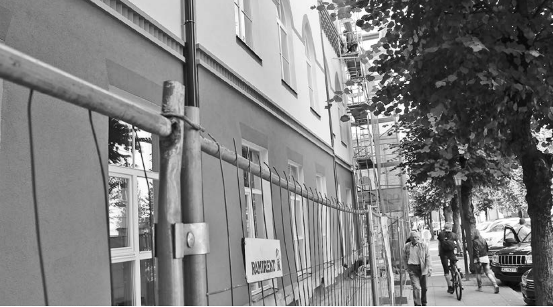
Attēlā: Pastariņa skolas rekonstrukcija rit raiti, un ēkas Raunas ielas fasādes atjaunošana jau tuvojas noslēgumam. Foto: Aivars Akmentiņš.
