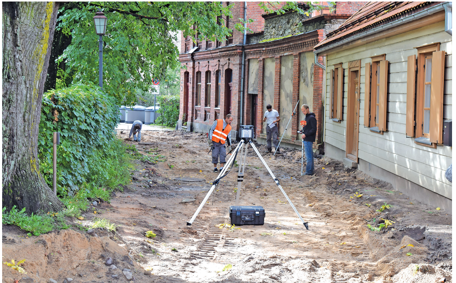
Attēlā: Lielajā Kalēju ielā šogad ieklās šķemboto pamatni, bruģa seguma klāšanu un citus darbus pabeigs nākamgad. Foto: Aleksandrs Abramovs.
