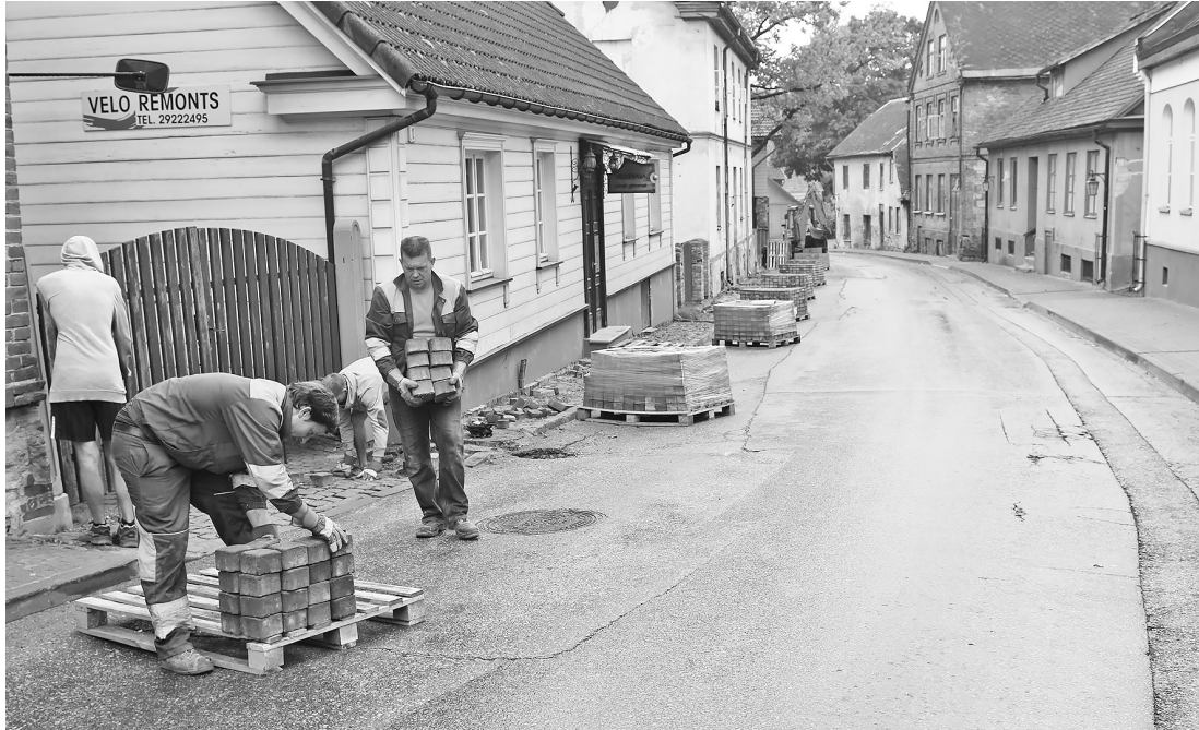
Attēlā: Vasaras nogalē remontdarbi sākušies arī Palasta ielas posmā no Bērzaines līdz Gaujas ielai. Remontdarbi ilgs aptuveni trīs nedēļas. Darbu laikā tiks atjaunots ceļa segums un gājēju trotuārs. Foto: Aivars Akmentiņš.
