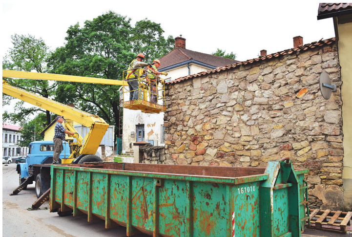
Attēlā: Pēc lietavām steigšus bija jāveic glābšanas darbi Vaļņu ielā, jo ūdens bija izskalojis mūra pamatus. Foto: Aleksandrs Abramovs.
