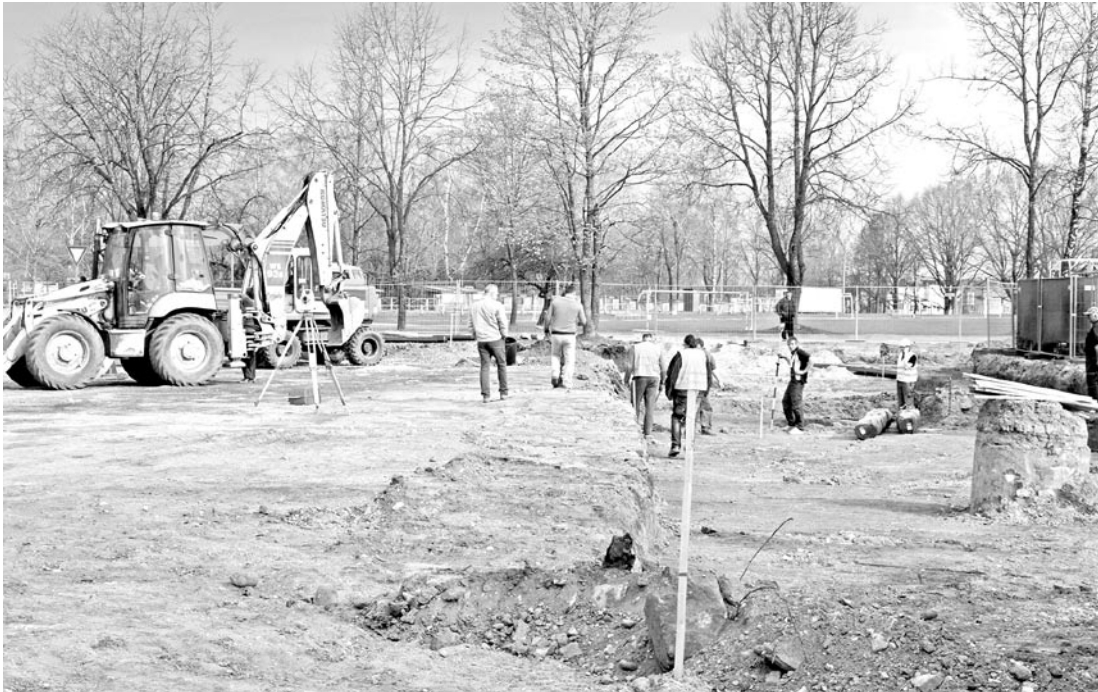
Attēlā: Smilšu laukumā jau sākta zemes virskārtas norakšana un Raiņa ielas posma uz Stacijas laukumu izbūve.
