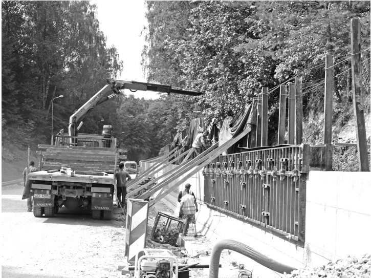
Attēlā: Gaujas kalnā noslēgumam tuvojas atbalsta sienas izbūve. Foto Aivars Akmentiņš.
