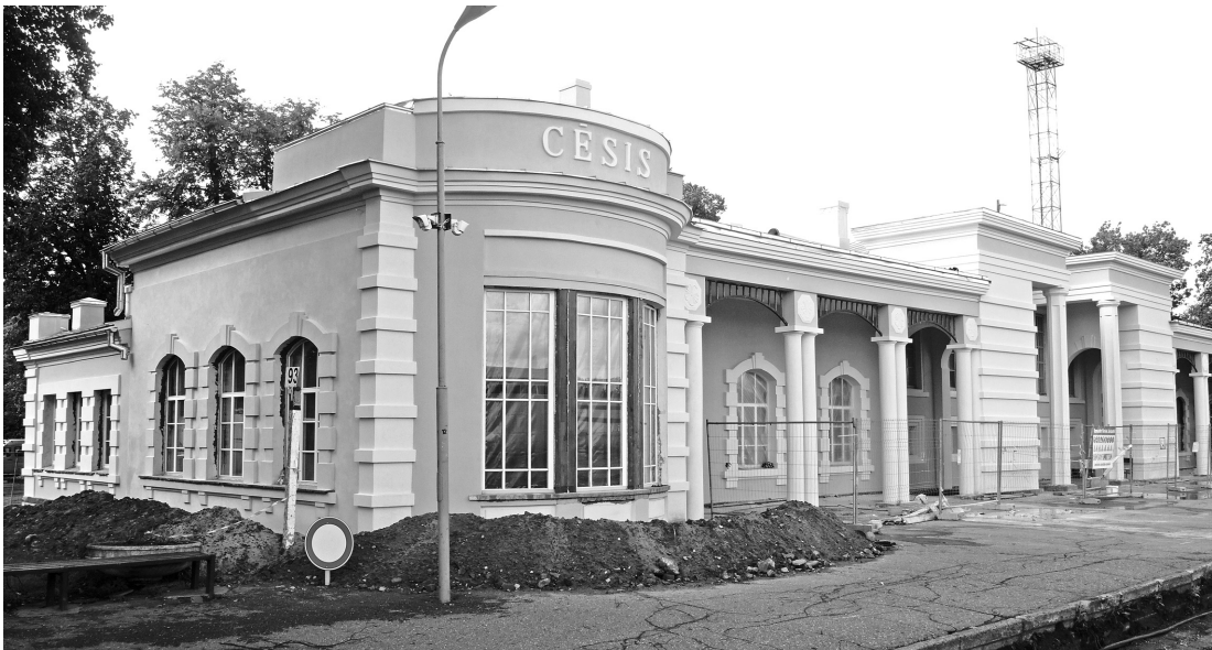
Attēlā: Pēc rekonstrukcijas stacijas ēka būs apsildāma, labiekārtota un ērta gan darbiniekiem, gan pasažieriem.
