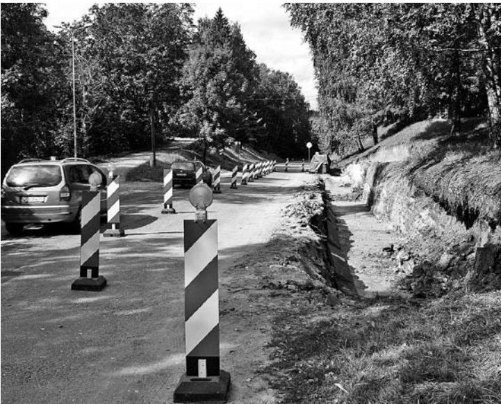
Attēlā: Augustā ir uzsākta Gaujas ielas nogāzes stiprinājuma izbūve un transporta satiksme traucēta tikai nelielā ielas posmā. Foto: Aivars Akmentiņš.
