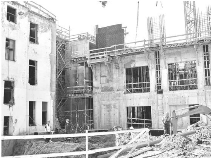
Attēlā: Vidzemes mūzikas un kultūras centrā notiek otrā un trešā stāva konstrukciju betonēšanas darbi.
