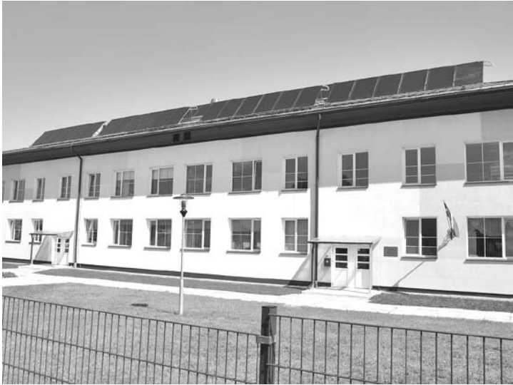
Attēlā: Saules kolektori uzstādīti uz 3. bērnudārza jumta. Foto: Aivars Akmentiņš.
