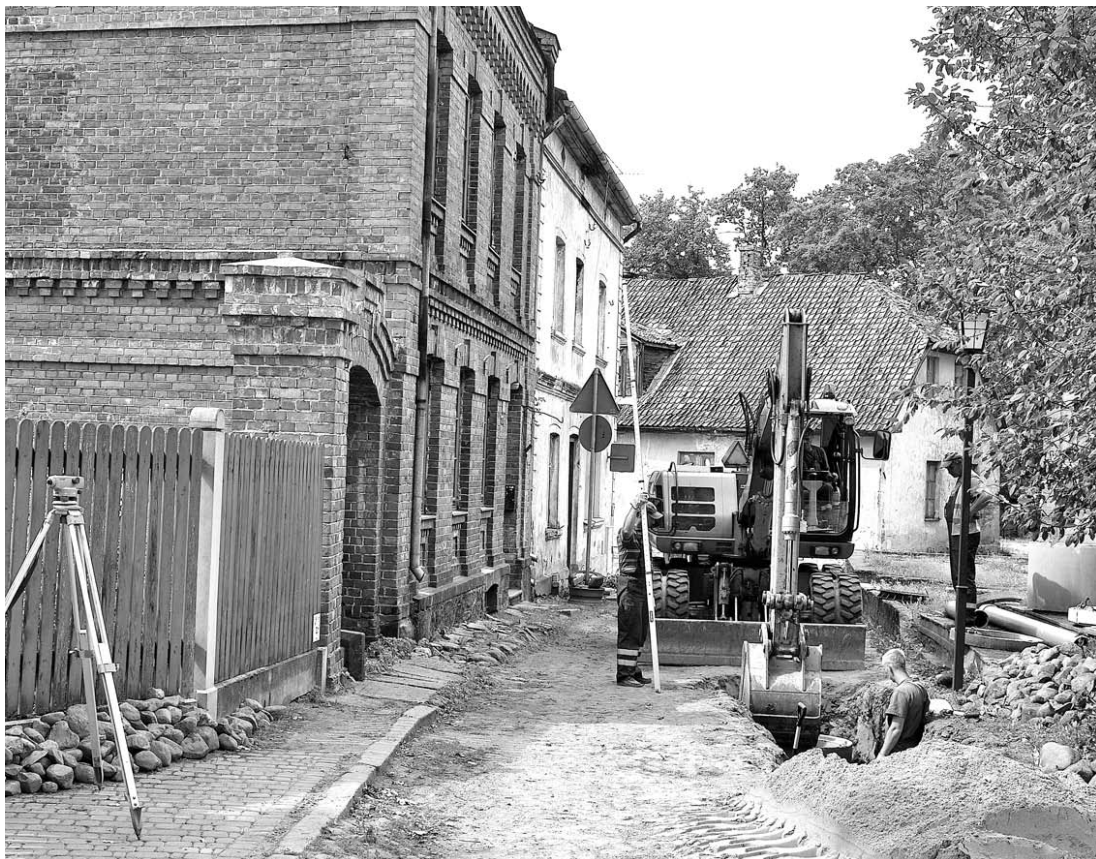
Attēlā: “Water Ser” speciālisti atjauno ūdensvada un kanalizācijas tīklus Mazajā Katrīnas ielā. Foto Aivars Akmentiņš.
