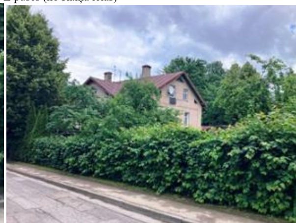
Ēkas fasāde no DR puses (no Zirņu ielas)
