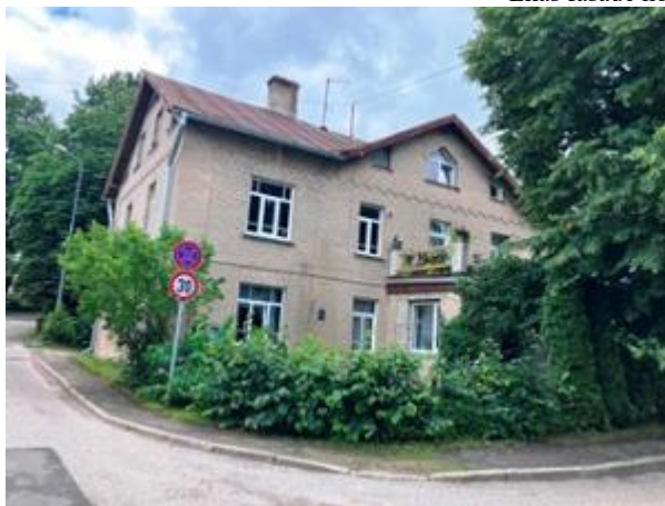
Ēkas fasāde no ZR puses (no Raiņa un Zirņu ielas)
