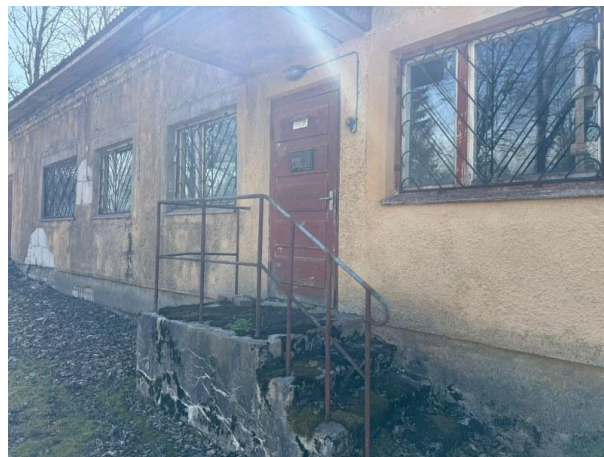
Ēkas fasādes daļa
