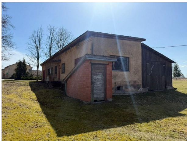
Ēkas fasādes daļa
