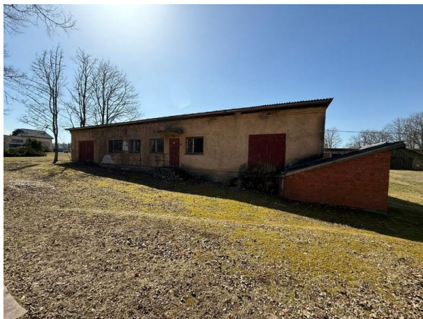
Ēkas fasādes daļa
