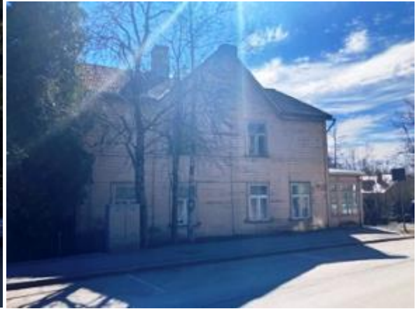
Ēkas fasāde no ziemeļu puses
