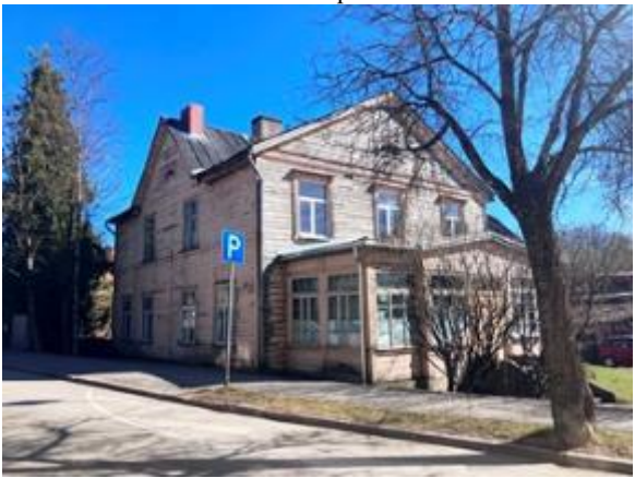
Ēkas fasāde no ziemeļrietumu puses
