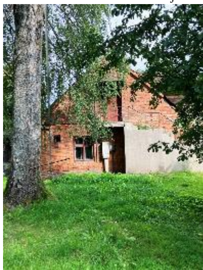
Mājas fasāde (no D)
