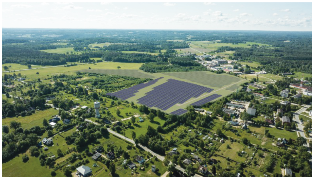
Attēlā: Saules ielas pļavā, starp Saulrītu un Vaives ielu, sākta jaudīgas Cēsu saules elektrostacijas būvniecība.
