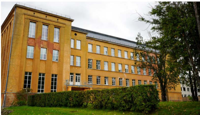
Cēsu Valsts ģimnāzijas pārbūve
