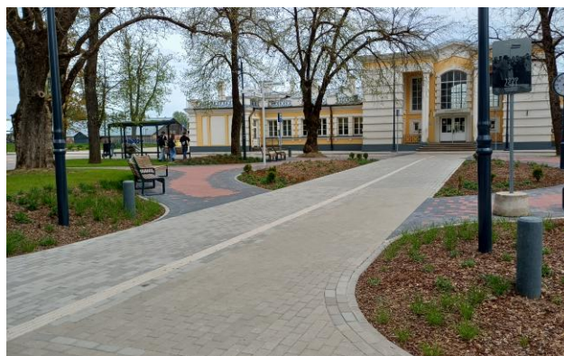
31. attēls. Bruģētie klājumi Stacijas laukumā, Cēsis ar lietusūdens noteci zaļā zonā. Autors I.Zicmane
